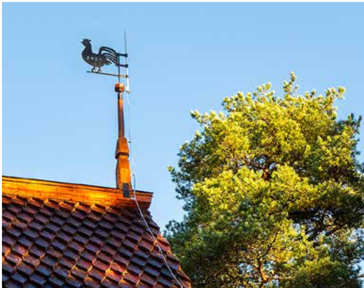
Korjaustöiden yhteydessä kirkko sai uuden paanukatteen ja uuden tuuliviirin.
